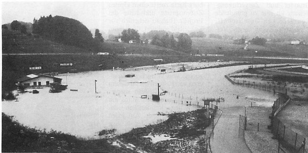
Von Naturkatastrophen blieb auch der Salzburg-Ring nicht verschont: ein Wolkenbruch führte am 20. Juli 1981 zu sintflutartigen Überschwemmungen, im Fahrerlager-Restaurant zeugt die über fensterbretthohe »Pegelmarke« noch heute davon.
