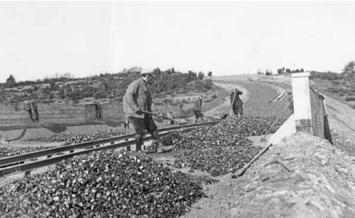
Arbeiter präparieren das Fundament im Abschnitt Schwalbenschwanz
