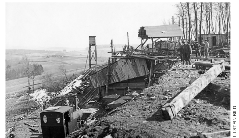
Mit Lorenbahnen wird das Baumaterial zur werdenden Strecke transportiert
